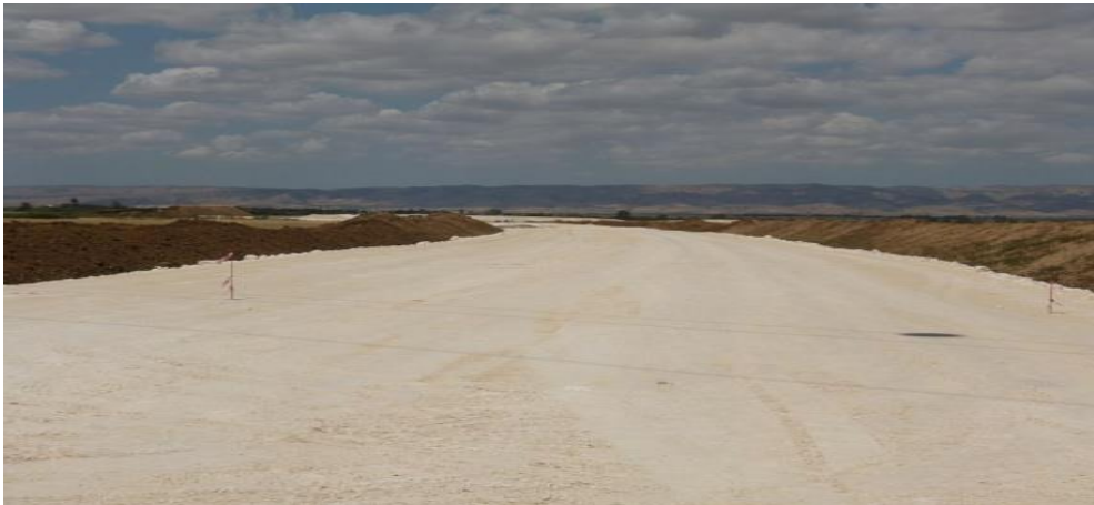
Figure 9. Réalisation de la couche d'assise en grave (0/31,5).
