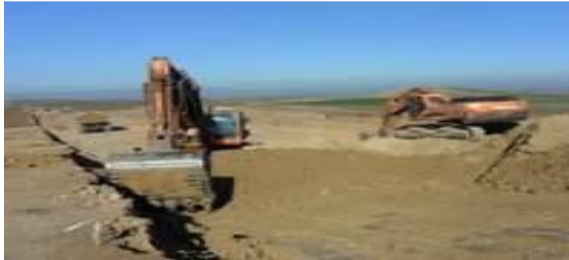
Figure 4. Travaux initiaux décapage de la terre argileuse
