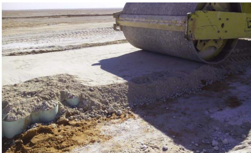
Figure 7. Mise en œuvre de la planche d'essai.
