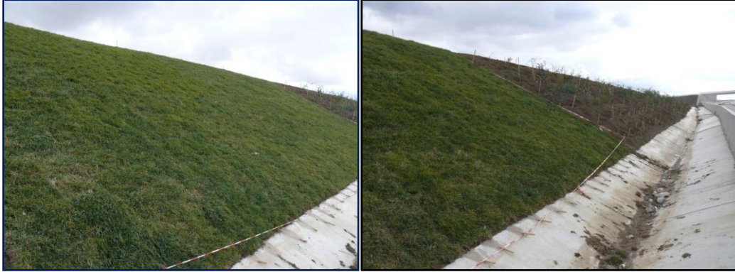
Figure 10 et 11 les talus marneux après traitement par les deux géosynthétiques.
