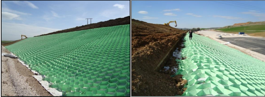
Figure7 et 8. Les deux géosynthétiques mis en œuvre.
