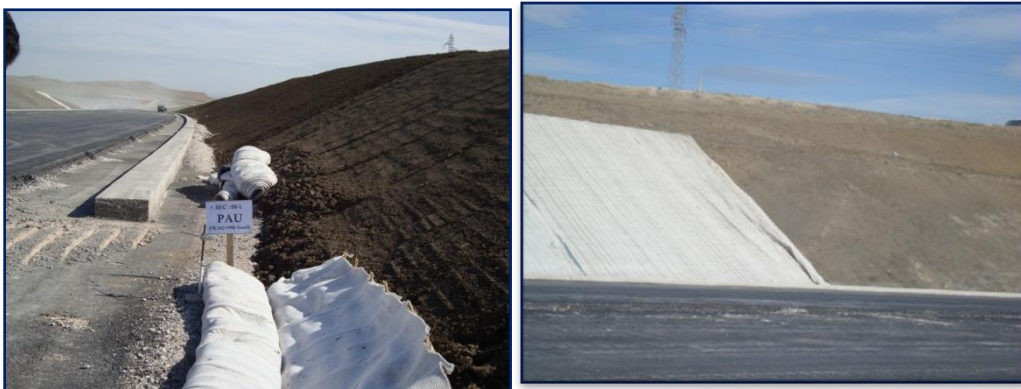
Figure 4 et 5. Mise en œuvre du géocomposite de drainage
