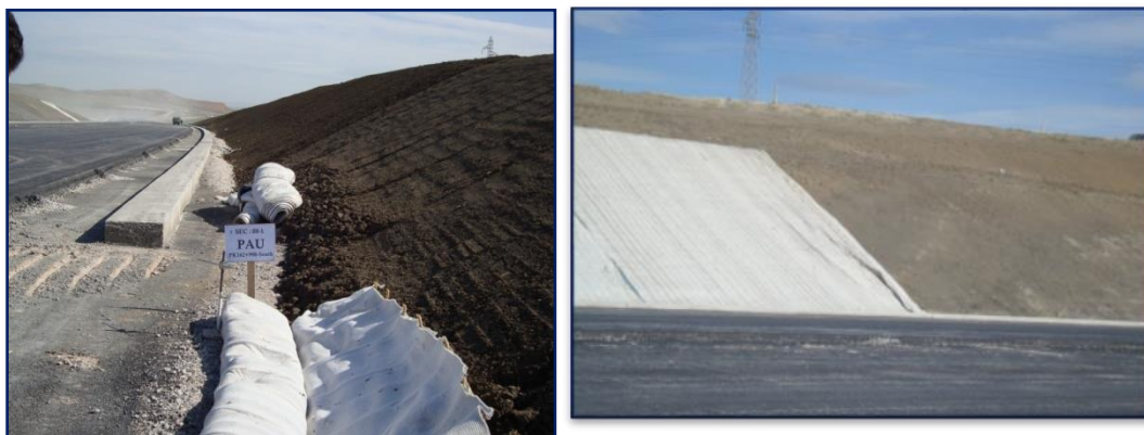
Figure 6. Mise en œuvre du géocomposite de drainage.
