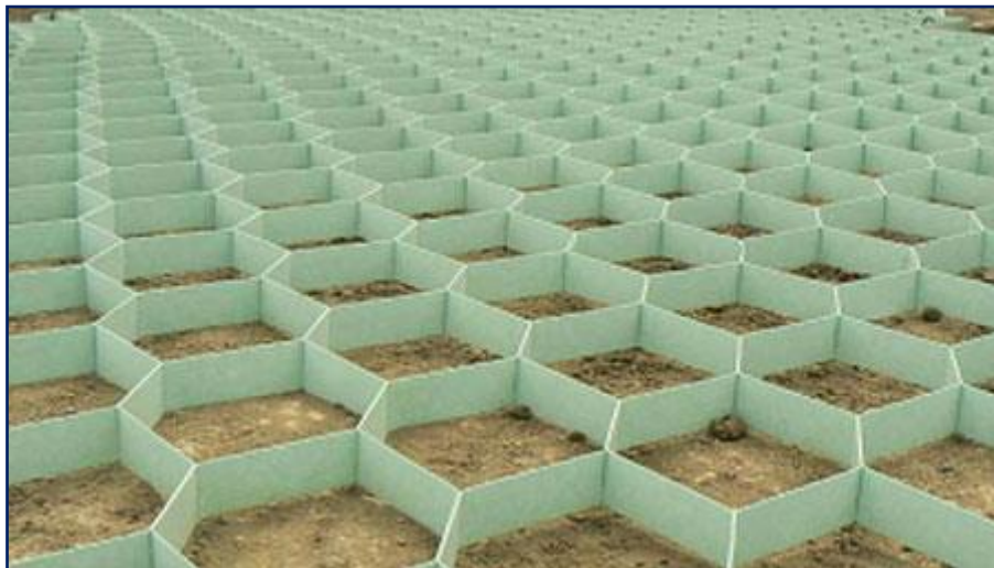
Figure 6. Structure du géosynthétique alvéolaire.
