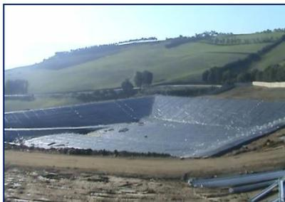
Figure 3. mise en œuvre de la geomembrane
