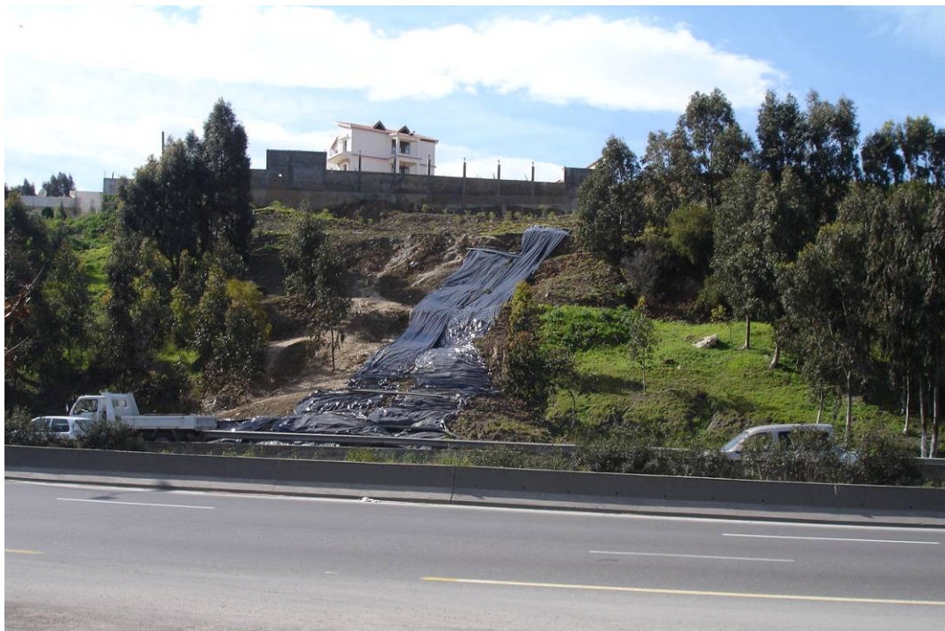
Figure 13. Déboisement total de la zone glissée
