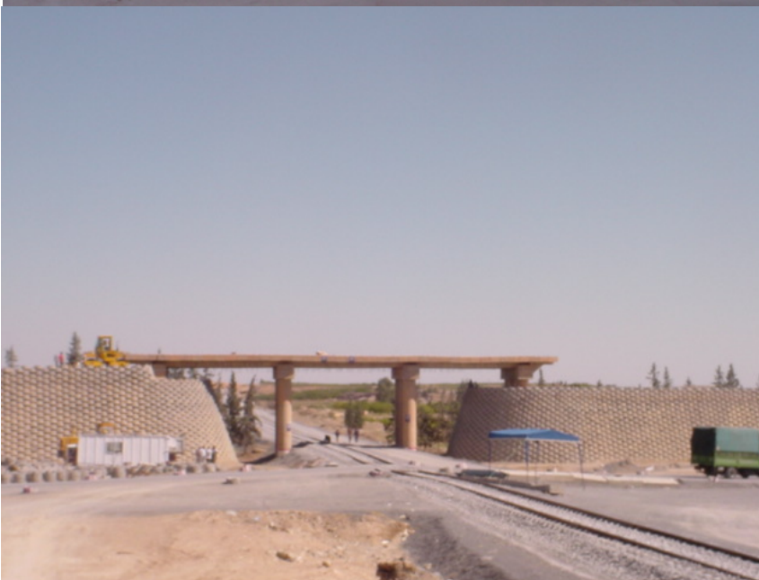
Figure 14. Vue de l'ouvrage en construction
