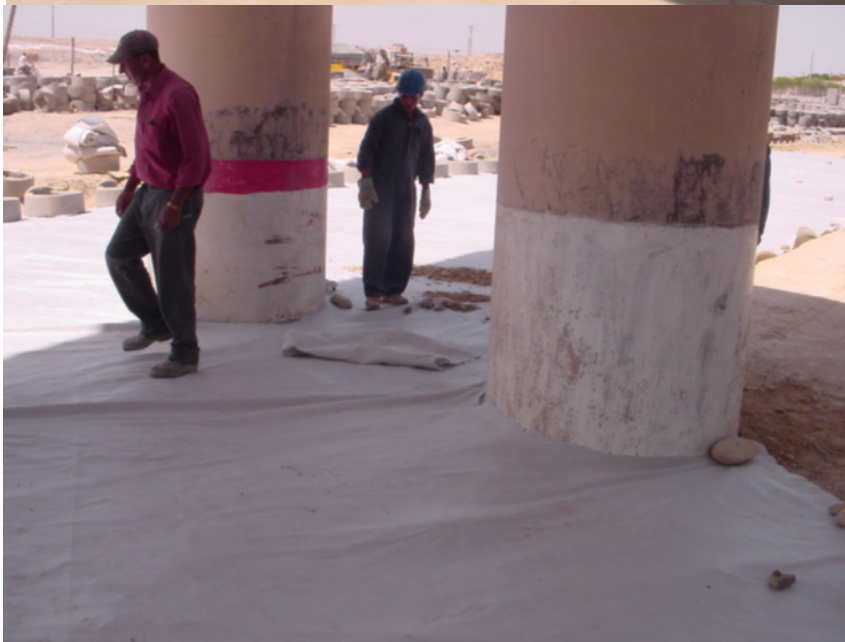
Figure 13. Détail de la pose des géotextiles au droit des piles
