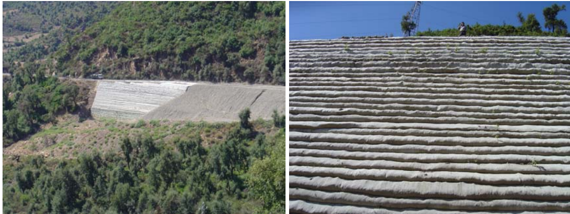
Photos 10 et 11 : vue de l'ouvrage achevé
