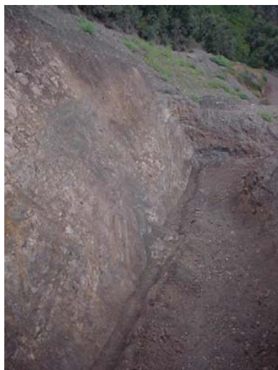
Photo 6 : Parement amont du massif et tranchée drainante
