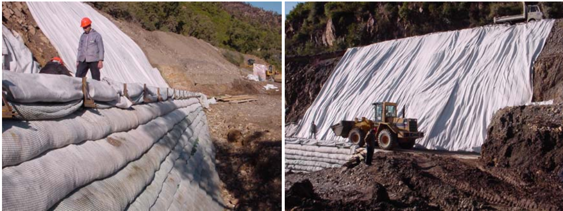
Photos 8 et 9 : Construction de l'ouvrage par couches
