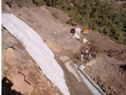
Photo 7 : Mise en œuvre du géocomposite de drainage
